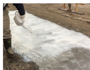
⑥PDゴムラテ養生剤の散布
