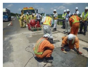
⑤打設状況
